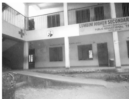
追加指標により 実現したスロープ
